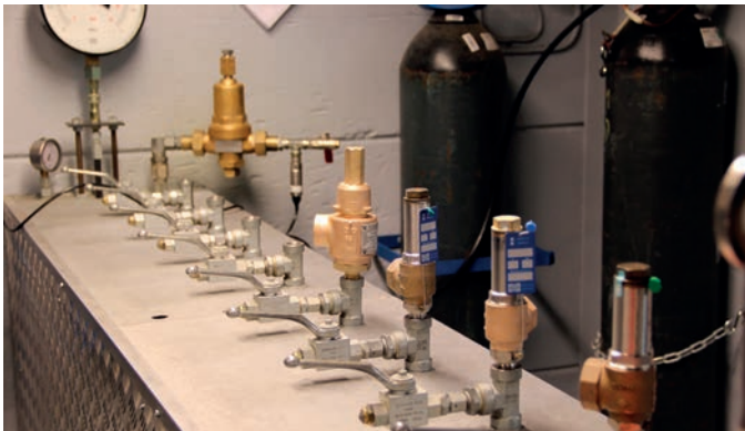
Kontroll av öppningstryck och täthet på säkerhetsventiler.
